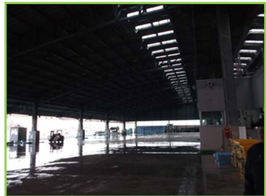
復旧された漁港の様子
